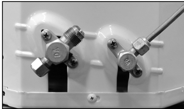
FIG. 31 - CONEXÃO DA LINHA DE EXPANSÃO DA UNIDADE CONDENSADORA
